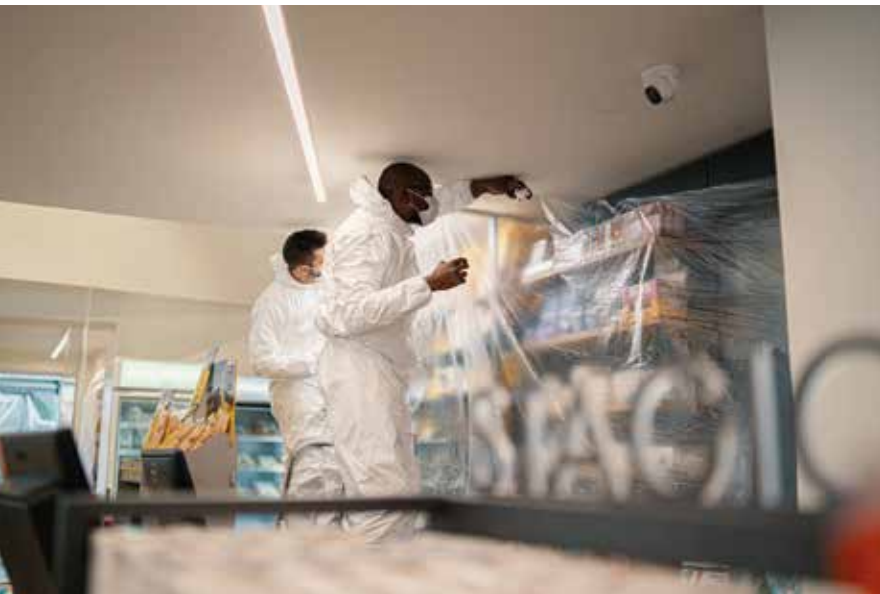
OPERATORI AL LAVORO NELL'APPLICAZIONE DEL COATING FOTOCATALITICO
