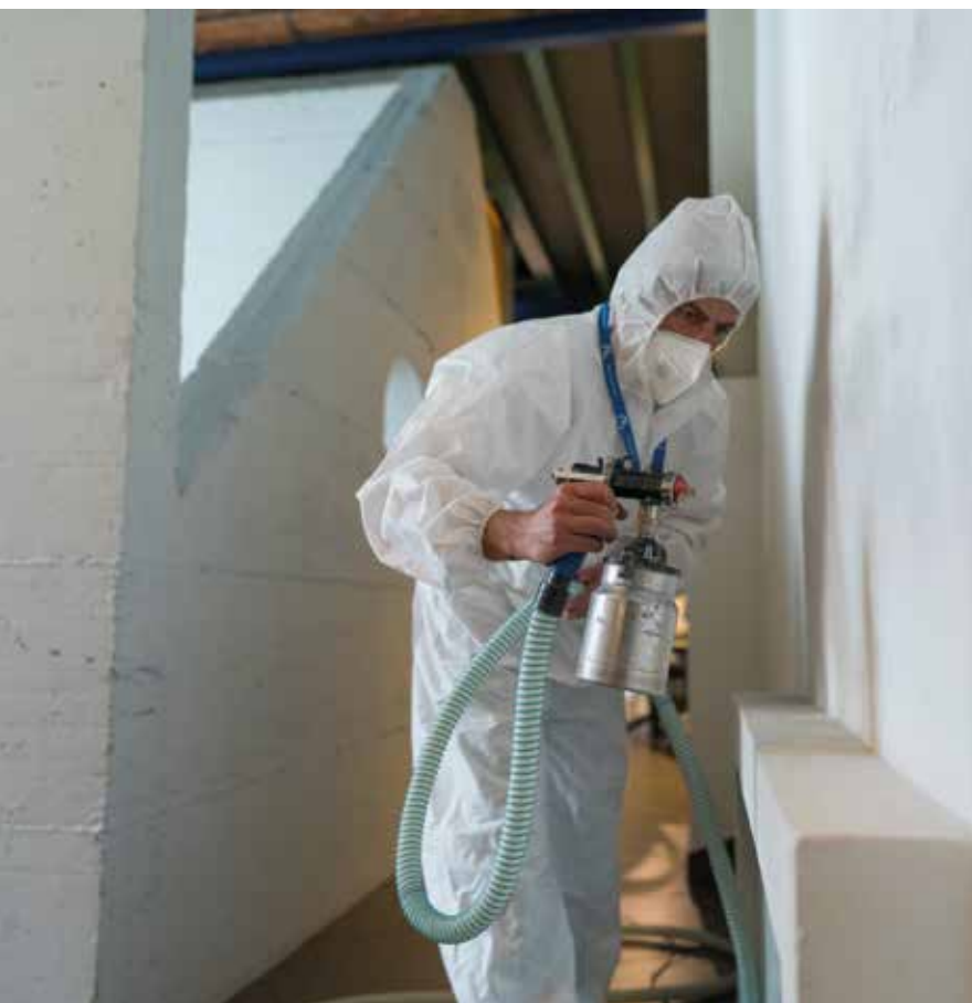
APPLICAZIONE COATING FOTOCATALITICO
